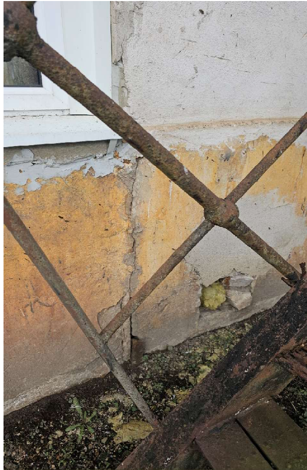
1 pav. Vertikalių tarp blokinių siūlių defektai.
