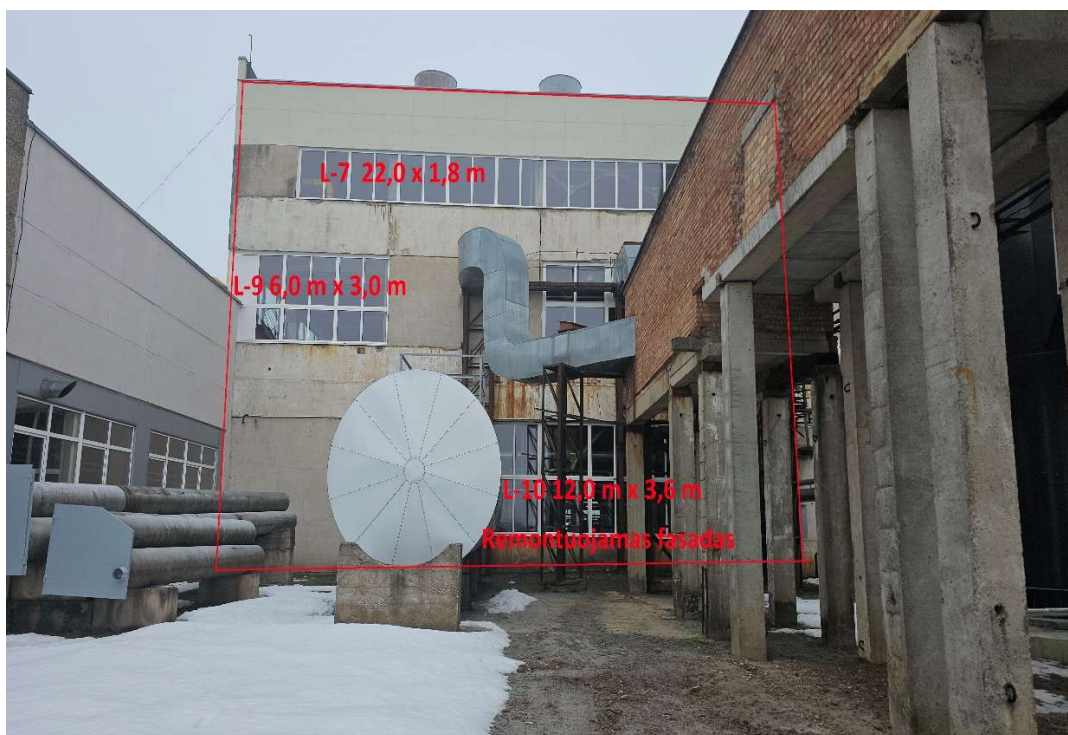
1 Pav. Remontuojamo fasadas su langų matmenimis, fasado tęsinys 2 nuotraukoje.
